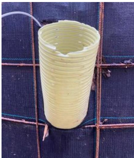
27. ábra Levegőztető, perforált Drain cső (saját kép)
