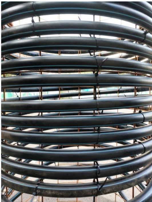
12. ábra Spirálisan haladó KPE csövek (saját kép)
