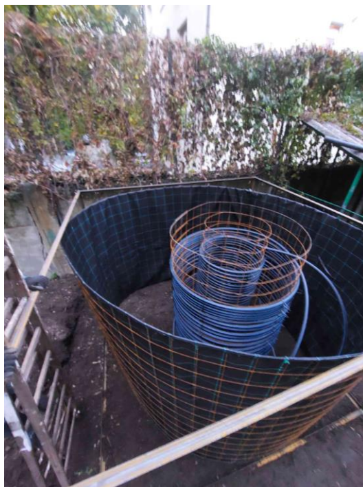
14. ábra Dupla spirális hőcserélő komposztálóban (saját kép)
