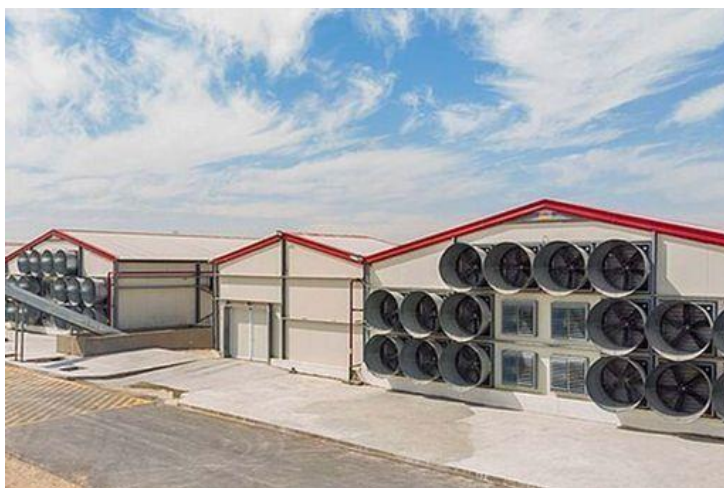
7. ábra: Tojóttyúk tartás automatizált szellőztetéssel, a képen látható ventilátorok 65Pa-nyi nyomásra képesek alacsony zajszint mellett ( http20 ).
