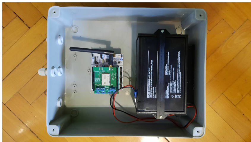
8.5. ábra. Összeszerelt panelek beépítve a helyükre
