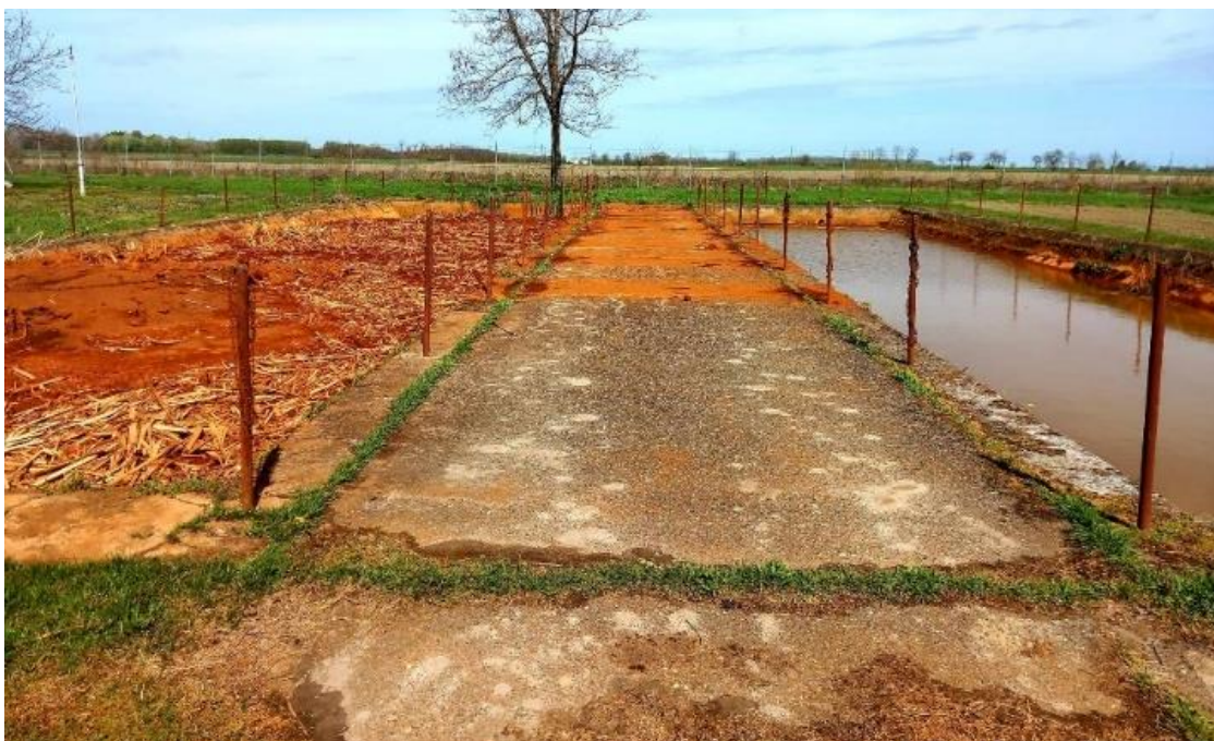
5. fotó: A vas és mangán talanító tartályok tisztítása során használt víz dekantáló medencéi a Foktő-barákai vízműben, Szerző által készített fotó 2024.03.29
