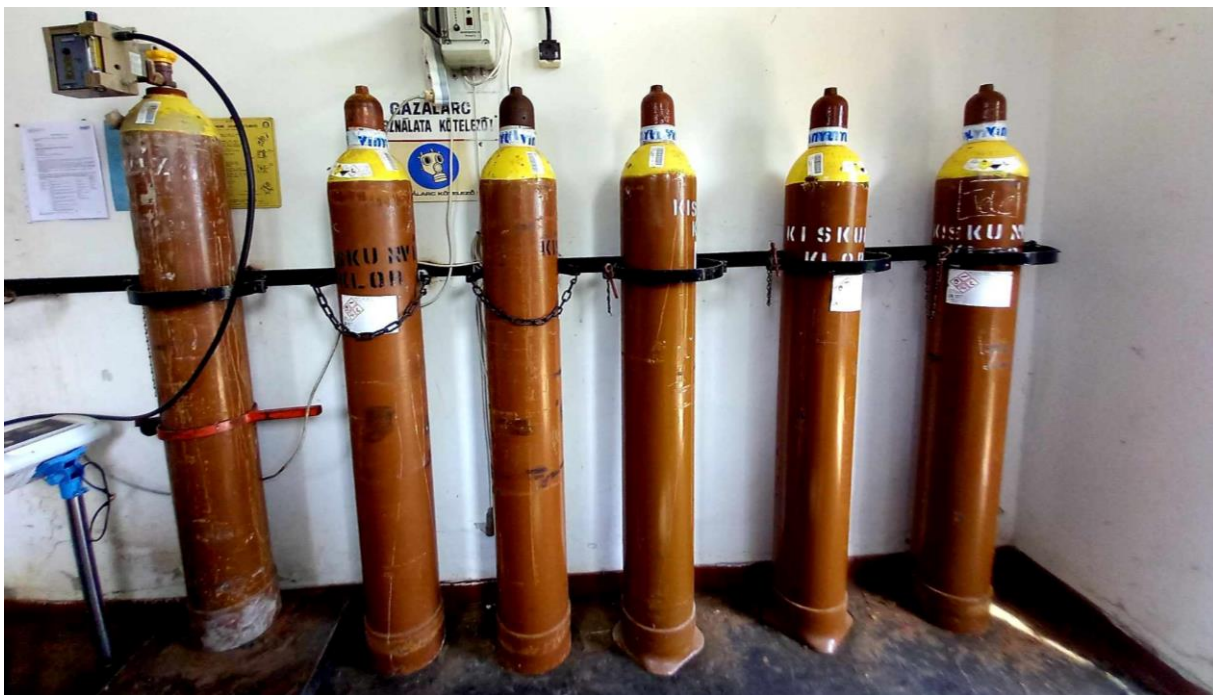
3. fotó: A Foktő-barákai vízműben az ivóvíz fertőtlenítésére használt klórpalackok Szerző által készített fotó 2024.03.29.
