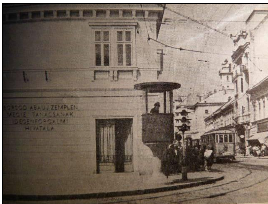
3. ábra: A hejőcsabai villamosvonal csatlakozása a fővonalhoz a Villanyrendőrnél (forrás: Pinterest)
