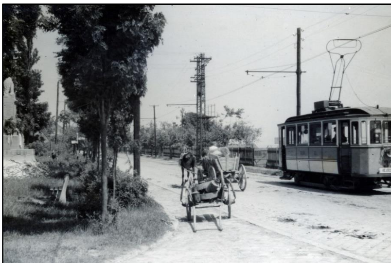
2. ábra: A hejőcsabai villamosvonal a tapolcai elágazásnál. Balra, a kis parkban az 1921. augusztus 21-én felavatott I. világháborús emlékmű látható, melyen a 32 hazájáért hősi halált halt hejőcsabai katona neve van megörökítve. A fotó 1939-ben készült. (forrás: Fortepan, 231776-os számú kép)
