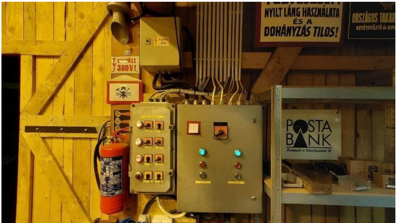
14. ábra Pajta főelosztó és kapcsolótábla, fent Szarvasi jelzőkürt (saját kép)
