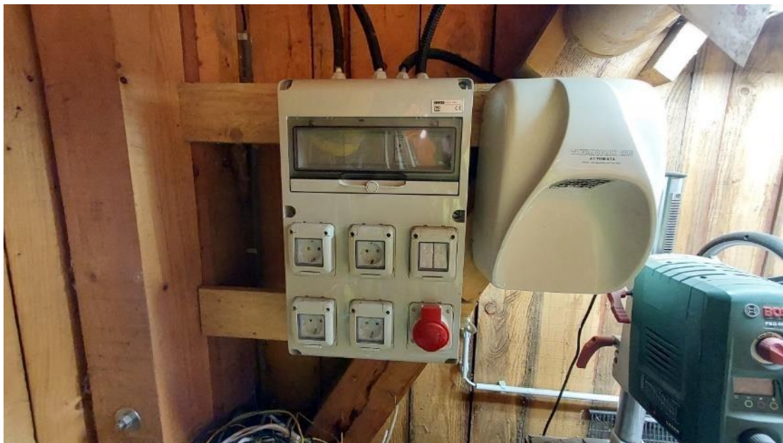
9. ábra GEWISS kombinált dugaszoló aljzat (saját kép)
