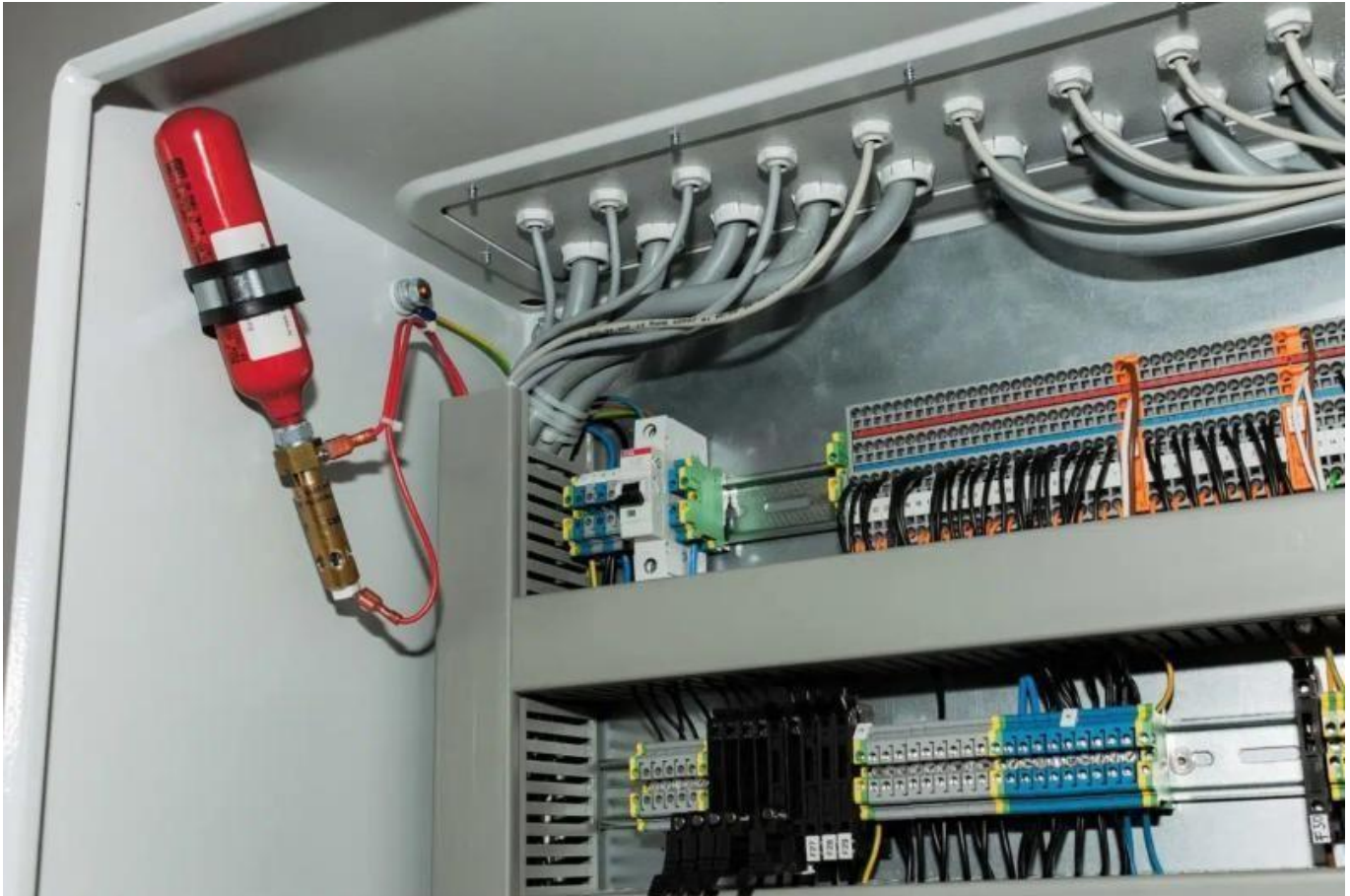
1. ábra CO 2 -vel automatikusan oltható elosztó (forrás: Energy Supply)
