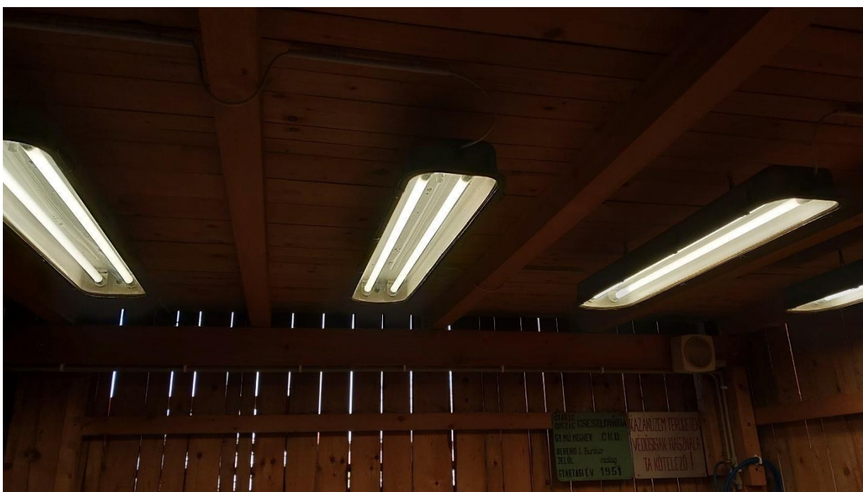
19. ábra 2x40W EKA fénycsövesek retrofit LED fénycsövekkel (saját kép)
