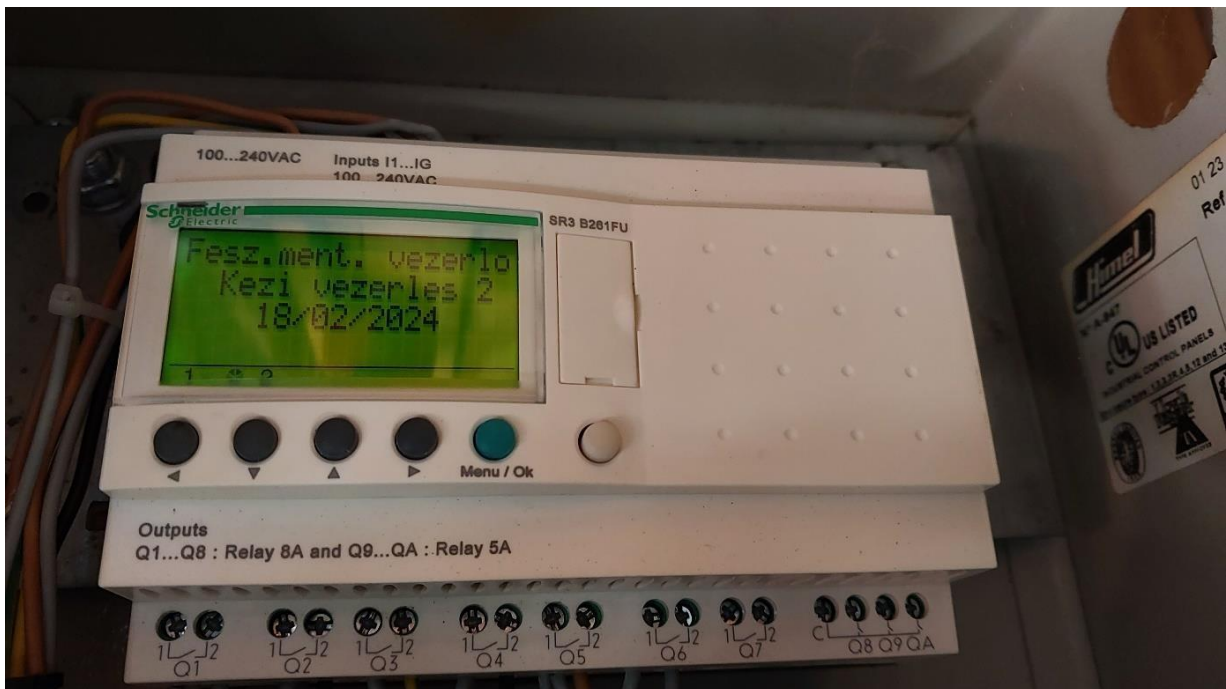
28. ábra PLC kézi vezérlés funkció (saját kép)
