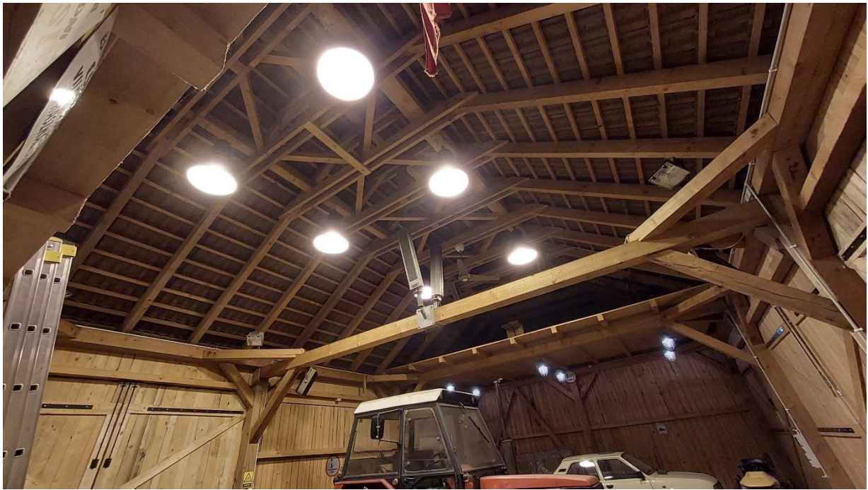
16. ábra 250W nátriumos Elektrosvit csarnoklámpák (saját kép)
