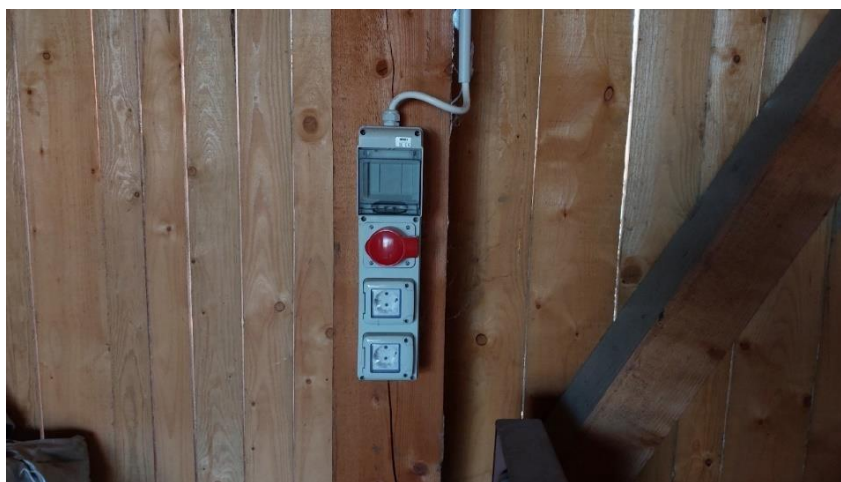
12. ábra GEWISS kombinált dugaszoló aljzat 5x2,5mm 2 betáplálással (saját kép)
