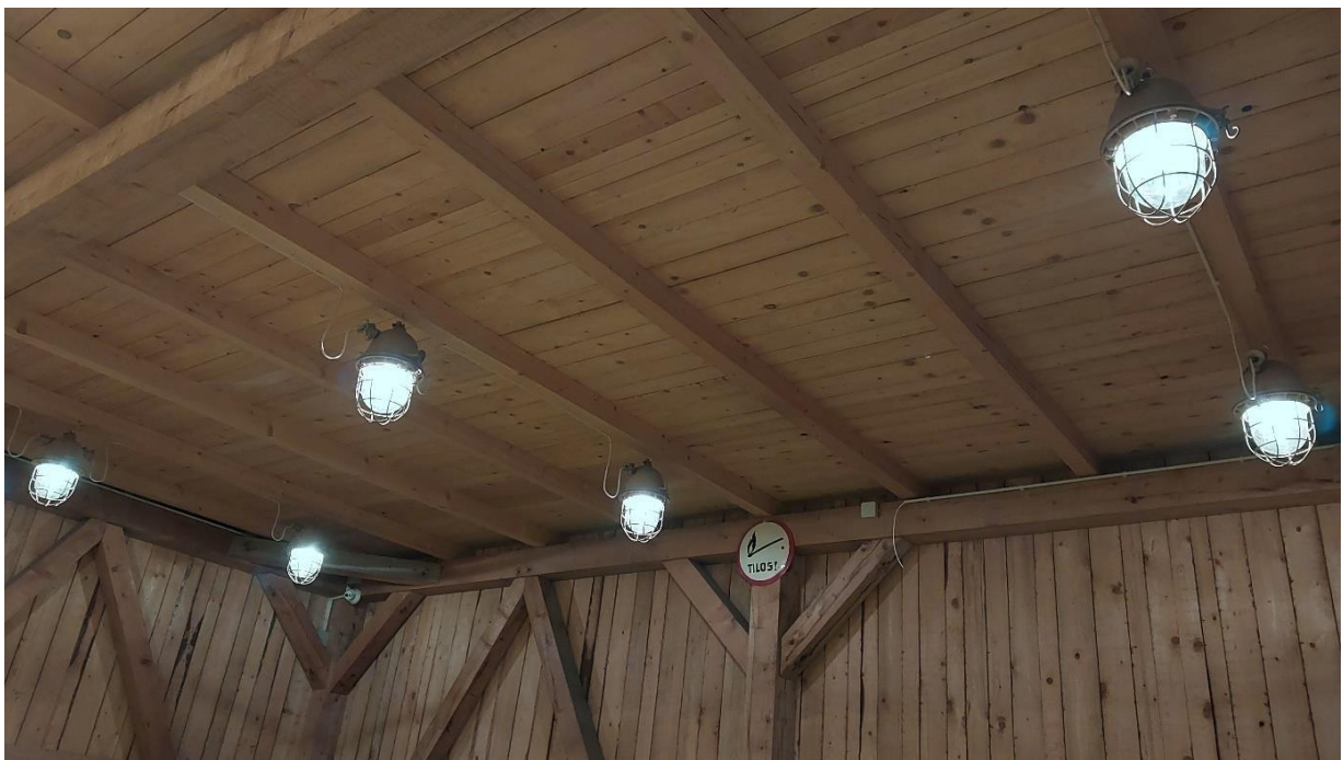
17. ábra EOW Rb 60W lámpatestek (saját kép)
