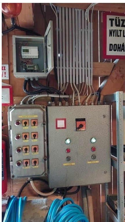
13. ábra Pajta főelosztó (saját kép)
