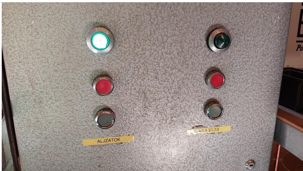
25. ábra Világítási és dugalj áramkör engedélyezési nyomógombjai (saját kép)
