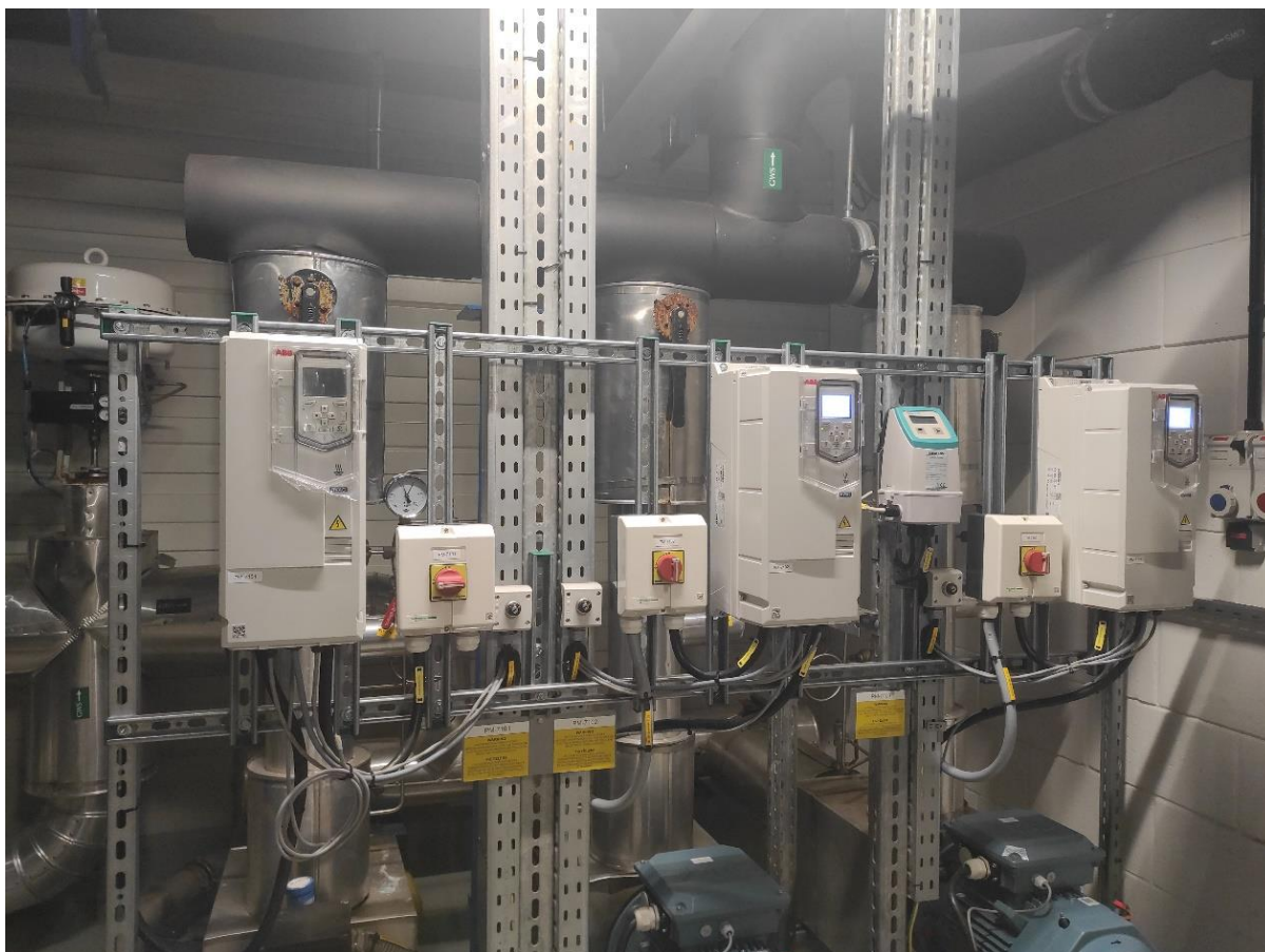
6. ábra A párhuzamosan kapcsolt szivattyúk
