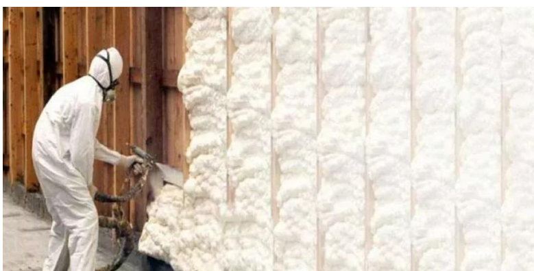
8.ábra: tartószerkezet szórt poliuretán hőszigetelése [14]
