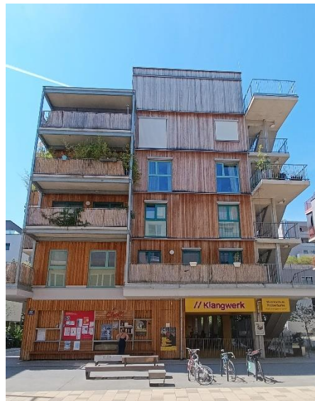
29. ábra Az épület homlokzata
