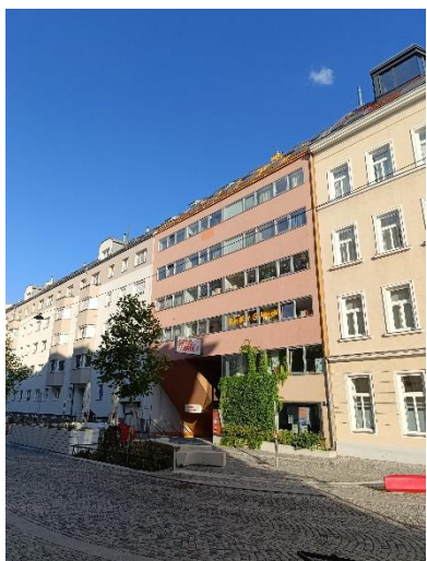
12. ábra Az épület utcafronti homlokzata forrás: saját fotó, 2024
