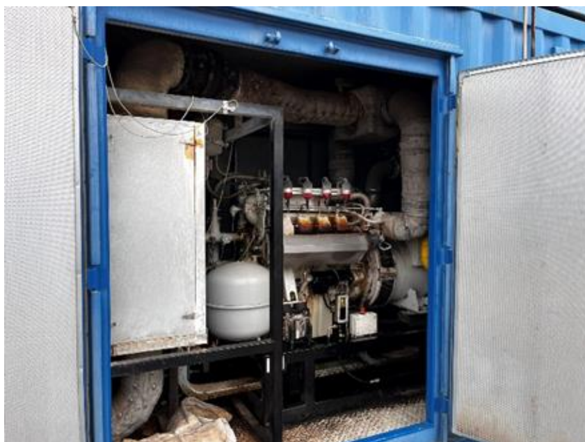
8. ábra: Gázmotor a szennyvíztisztító telepen (forrás: Szabó László főmérnök fotója)
