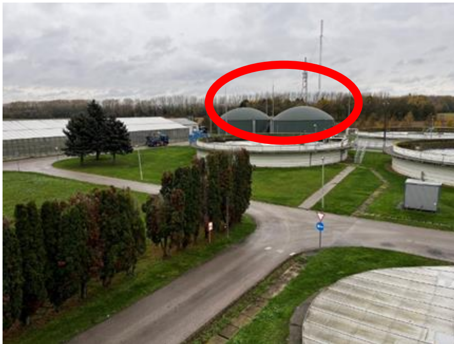
7. ábra: WELTECH mezofil iszaprothasztók piros színnel bekarikázva (forrás: Szabó László főmérnök fotója alapján saját szerkesztés)
