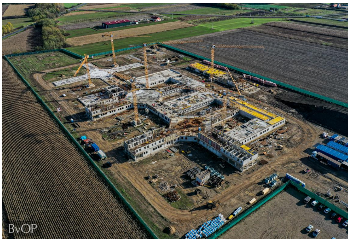
15. ábra A Csengeri Intézet építkezés munkaállapot 27
