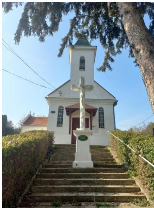
4.fénykép: Nyerges-kő 5.fénykép Szent Anna Kápolna (Saját fotó: 2024.10.23)
