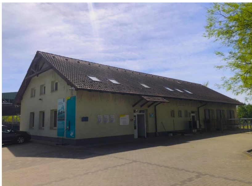
3. ábra: A vizsgált épület Fóton
