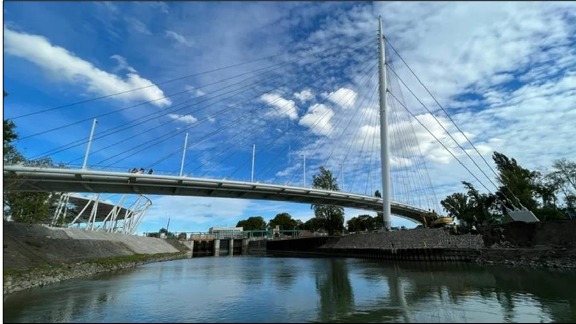
17. ábra: Hídszerkezet a hátrahorgonyzó kábelek bekötésével [16]
