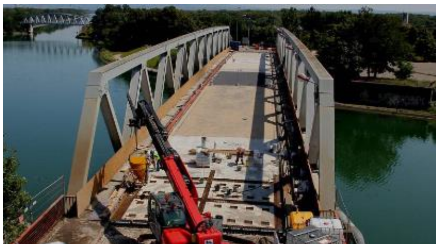
3. ábra: Ilzbach híd javítása UHPFRC-vel
