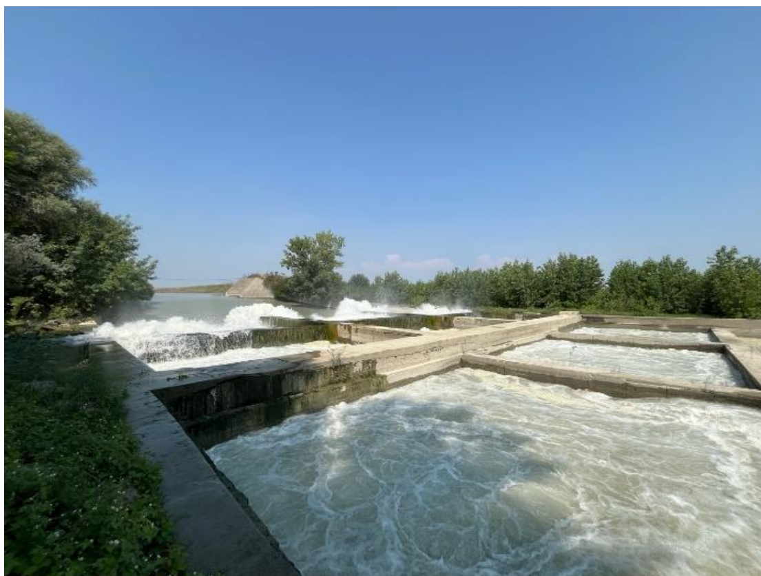
1. ábra Energiatörő a hűtővízesatornán
