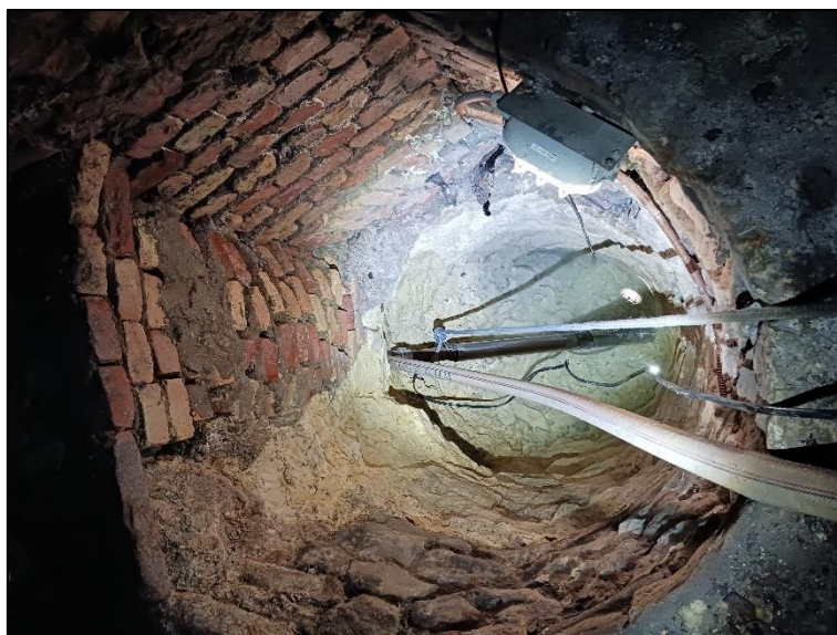
4. kép A Hadik kút szivattyúzása, 2024. febr. 26.
