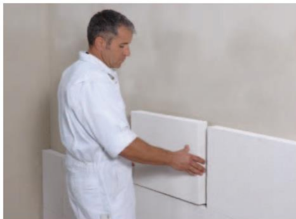
3.1 ábra. Multipor felhelyezése
