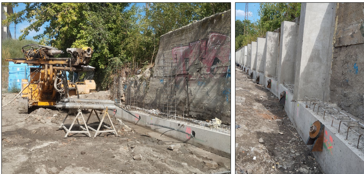
8. ábra: Horgonyzógép és talajhorgonyok fúrás után, valamint megfeszítve (saját fénykép)
