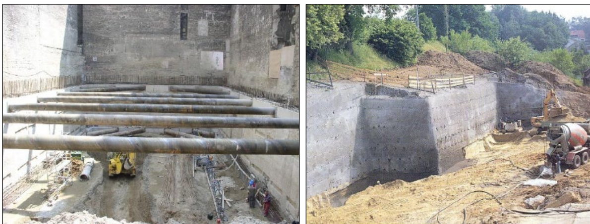
9. ábra: Acél dúcolatok és löttbeton fal (Móczár, 2023)
