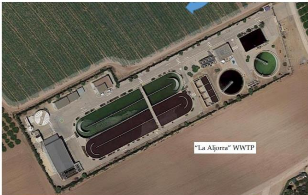
4s. ábra: Oxidációs árok a La Aljorra WWTP-ban (Bayo és mtsai, 2021)
