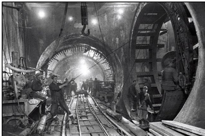
14. ábra: Az M2-es metróvonal építése (forrás: 24.hu/tudomany/2015/11/18/ritkan-latott-felvetelek-a-masodik-magyar-metrovonal-epiteserol )
