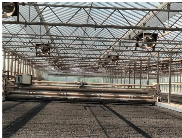
13. ábra: Törökszentmiklós szennyvíztelep SZOLÁR szárító
