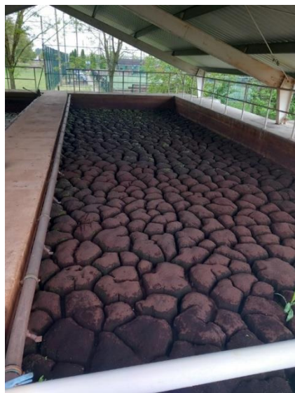
9. ábra: Hajdúnánás Vízműtelep iszap szikkasztó II. medence
