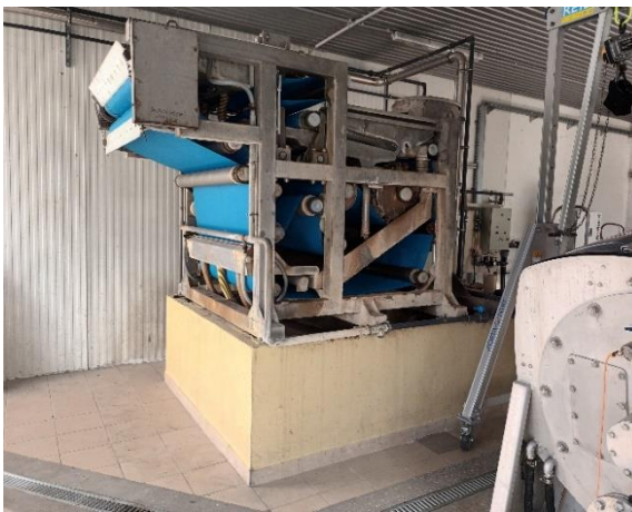
11. ábra: Törökszentmiklós szennyvíztelep szalagprés
