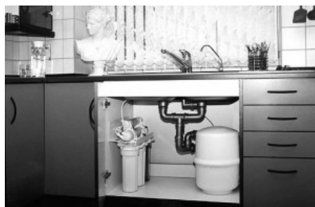
3.4. ábra. Beépített fordított ozmózis víztisztító rendszer [15]
