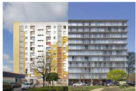
22. ábra. Lacaton & Vassal panelház átépítése, Bordeaux, Franciaország, 2.
