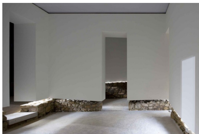
52. kép: új és régi falszerkezetek csatlakozása
