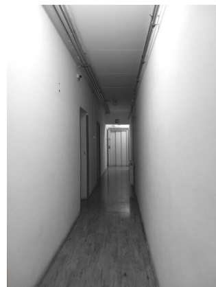
4.1.2. Földszint folyosó fénykép
