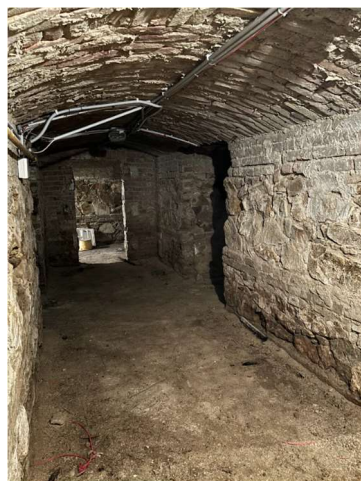
10-11. ábra: A pince két fajta helyisége, a padló döngölt föld, a falak kisméretű téglák. Saját fotók.
