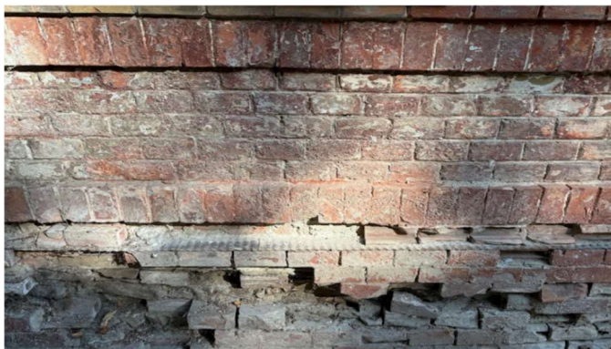
6. ábra: Vízzáró acéllemez, saját fotó
