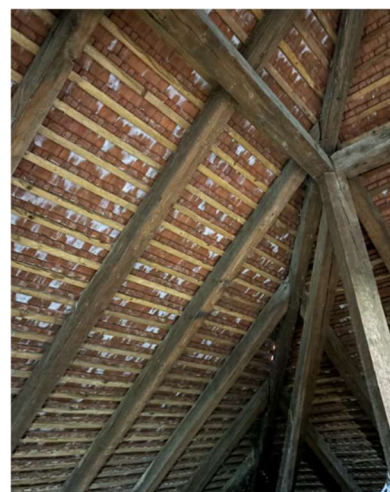
12. ábra: A két beépítetlen padlásrészben láthatóak az eredeti tetőgerendák, itt nem kellett gipszkarton borítást alkalmazni. Saját fotó.
