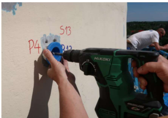
21. ábra: Furatpor mintavétel külső felületről (forrás: ORISOFT Mérnöki Építő és Tanácsadó Kft: A mezőkovácsházi vasbeton silók statikai állapotáról készített Anyagvizsgálati és tartószerkezeti szakvélemény, 2024)
