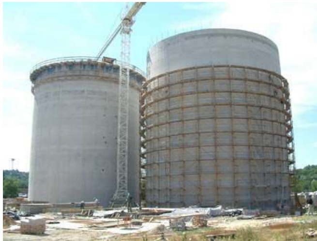
6. ábra: a Kaposvári Cukorgyár fermentor silóinak csúszózsálas kivitelezése (forrás: https://www.epitesimegoldasok.hu/20100122nagymeretu_silok_epitese_zsuszoszsaluval.html , letöltés ideje: 2024.09.15.)
