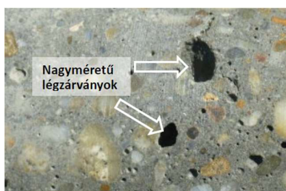
20. ábra: Légzárványok a szerkezetben (forrás: ORISOFT Mérnöki Építő és Tanácsadó Kft: A mezőkovácsházi vasbeton silók statikai állapotáról készített szakvélemény)
