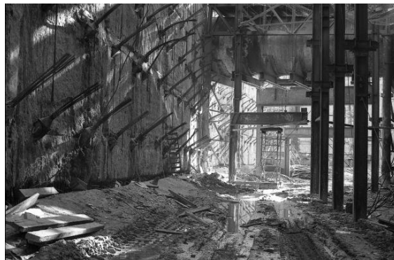
9. kép: Visszahorgonyzás, földmegtámasztás alapozás közben [10]
