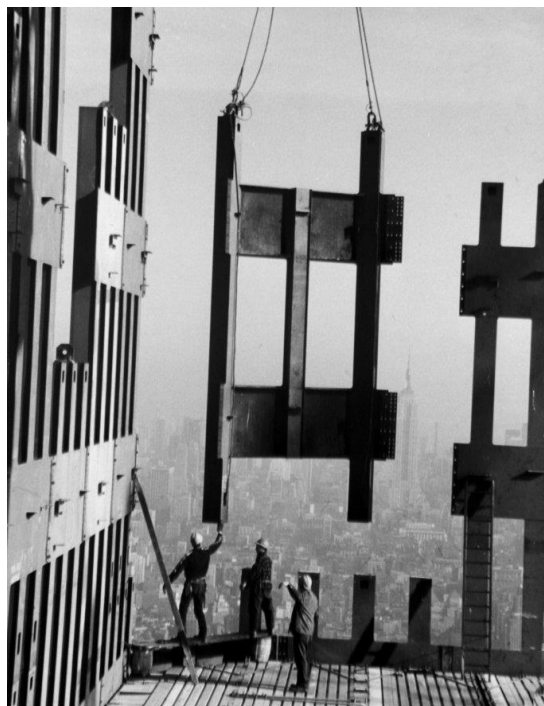
10. kép: Előregyártott elemek beemelése a pozíciójukba, jól érzékelhető dimenzió, amiben gondolkodni kellett [10]
