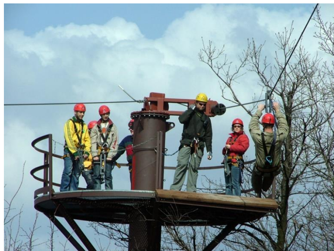
15. Ábra - Acél oszlopos csúszó kötélpálya
