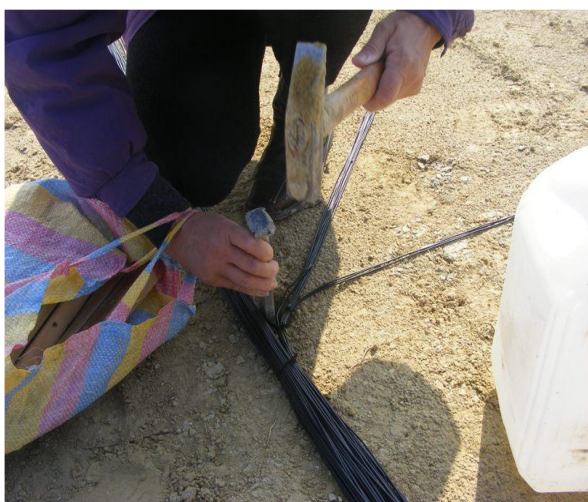
6. ábra: Elektróda beütése [5.]
