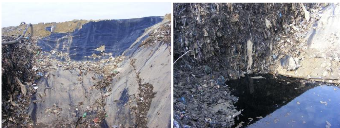
30. ábra: Fólia sérülések a rézsún és a medence aljának közelében [9.]
