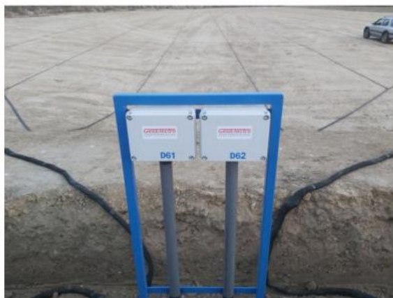
11. ábra: Az állványokra csavarozott csatlakozószekrények [5.]
