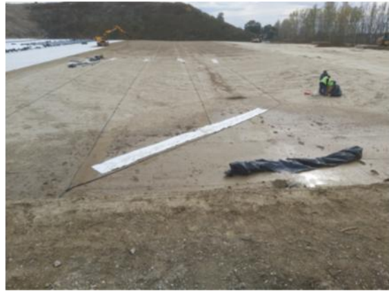
17. ábra: Szenzorhálózat telepítése [7.]
