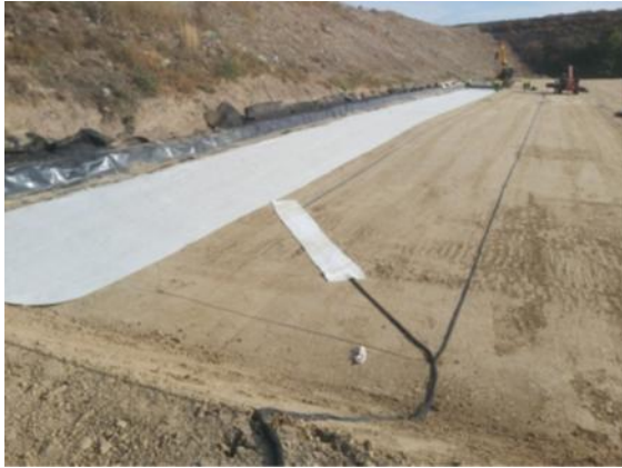
17. ábra: Szenzorhálózat telepítése [7.]
