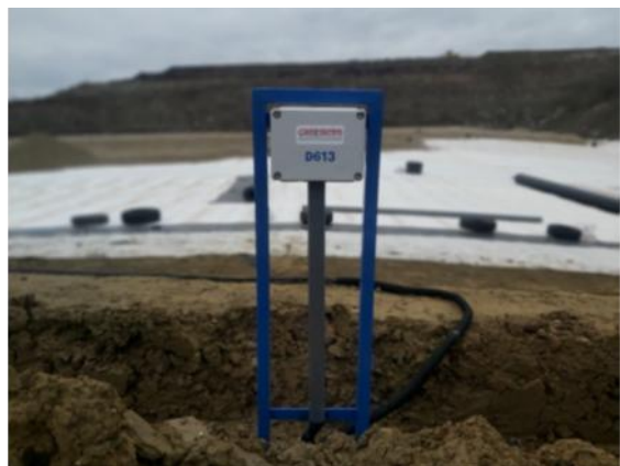
18. ábra: A telepített csatlakozó dobozok
