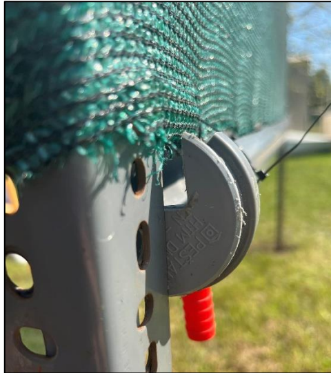
1. sz. kép: Gyűjtőcsatorna rögzítése a keretre (saját kép)
