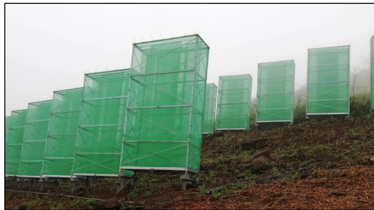
13. sz. ábra: Kanári-szigeteken lévő ködgyűjtők (Burgen, 2022)
