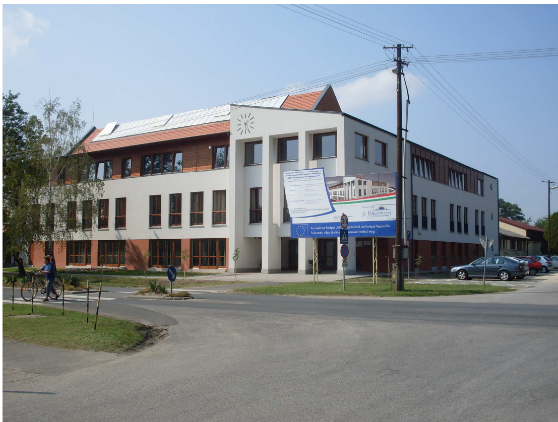
8. melléklet: Felújított általános iskola Forrás: saját készítésű kép
