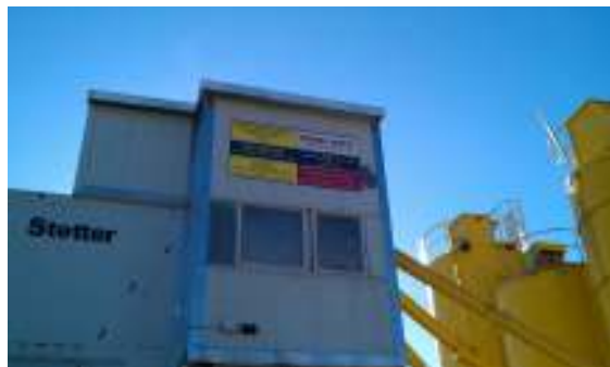
15. kép: Paksi betonüzem
