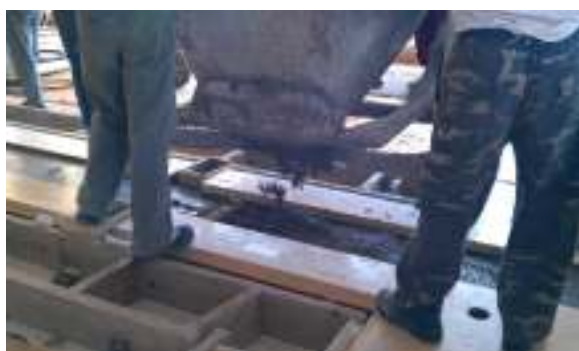
22. kép: Betonzás öntömörödő betonnal 1
