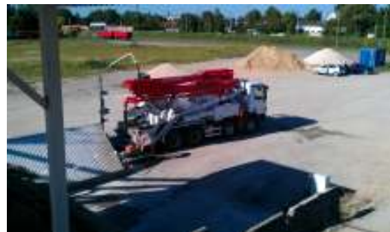
16. kép: Paksi betonüzem
