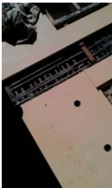
20. kép: Beszerelt betonacél 1
