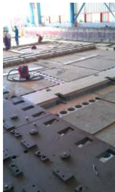
21. kép: Betöltő fedélzet építése 1
