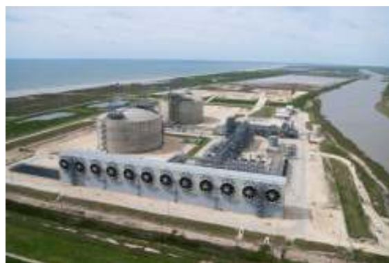
12. kép: Szabadtéri feszített betontartály, Japán
