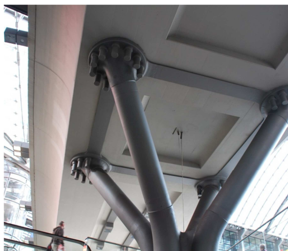
3.3. ábra – Acél oszlopra támaszkodó vb. szerkezet
