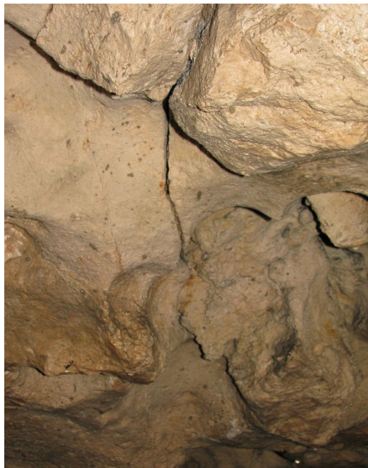
9. kép. 1 cm tágasságú repedés
