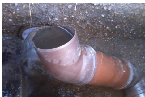
4-2. kép: A kifolyó cső szintjének megemelése
