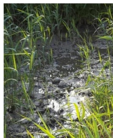
3-5. kép: Szennyvíz megjelenése a töltet felszínén
