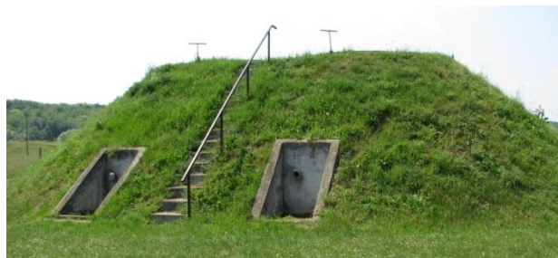
3-1. kép: Kétszintes előülepítő
