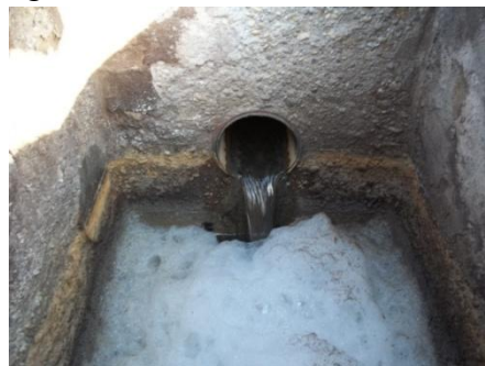
3-2. kép: A fertőtlenítő műtárgy befolyás felőli oldala
