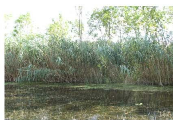
2. szakasz - kotrás alatt
