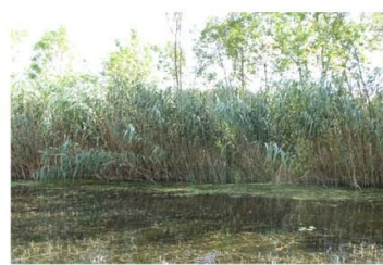
2. szakasz - kotrás alatt
