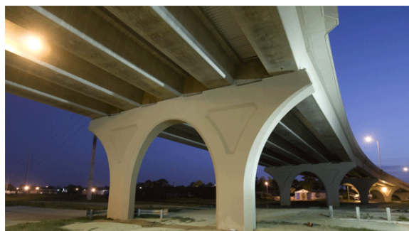
2. ábra: Közúti NT beton hidak: Hickman Road Bridge, Tennessee, USA és North Boulevard Bridge, Louisiana, USA (forrás: fhwa.org)
