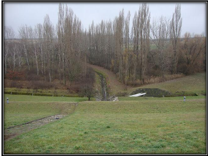
3. kép: A gát mentett oldali részűje és a Nyiget-patak burkolt medre
