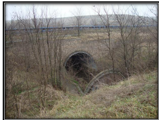
4. kép: A déli bánya északi részén lévő töltés alatti 6 m átmérőjű átereszt
