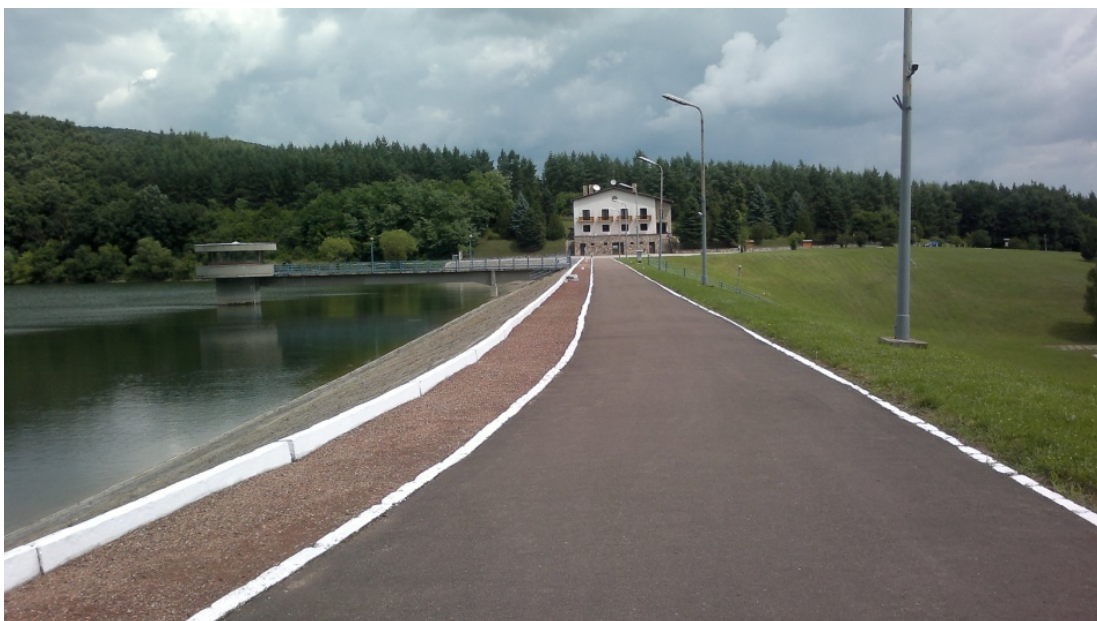
26. ábra: a lázbérci víztározó gátja a vízkivételi műtárggyal (saját fotó).
