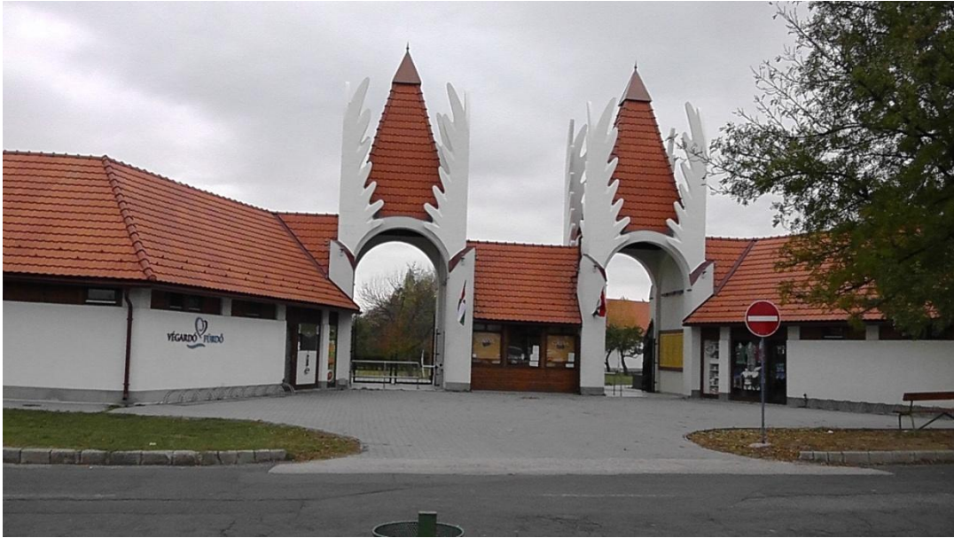
13. ábra Felújítás után a fürdő északi bejárata
