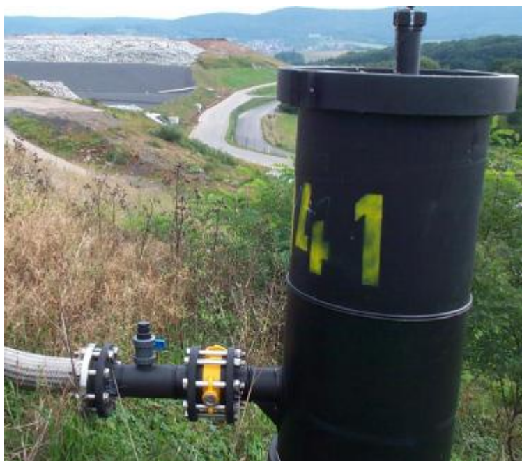
6. ábra: Egy korszerű, műanyag depóniagáz kút
