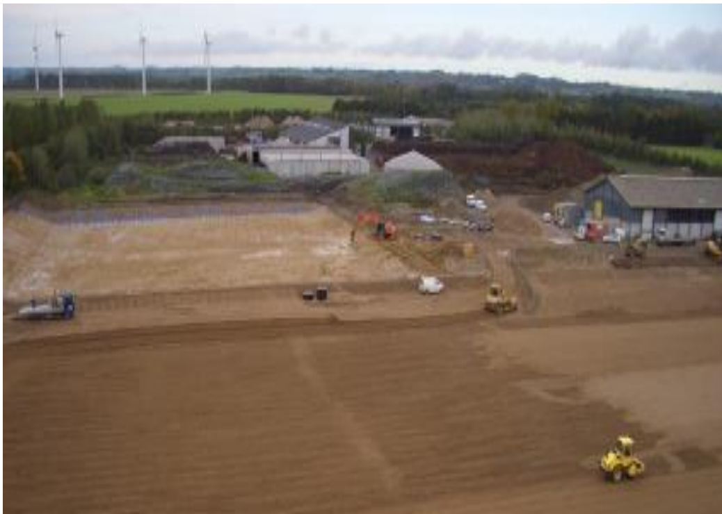
8. ábra: Depóniagáz telep a dániai Aubedóban
