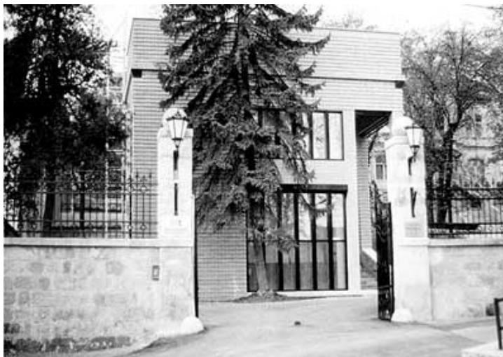
14. Kép: Törley-kastély portaépülete
