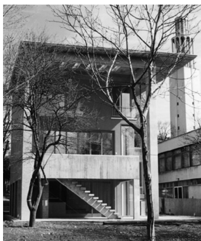
23. Kép: Tomay Tamás: Pasaréti úti villa kert felőli homlokzata a nappali üvegfalával [Fotó: Csajbók Csaba]
