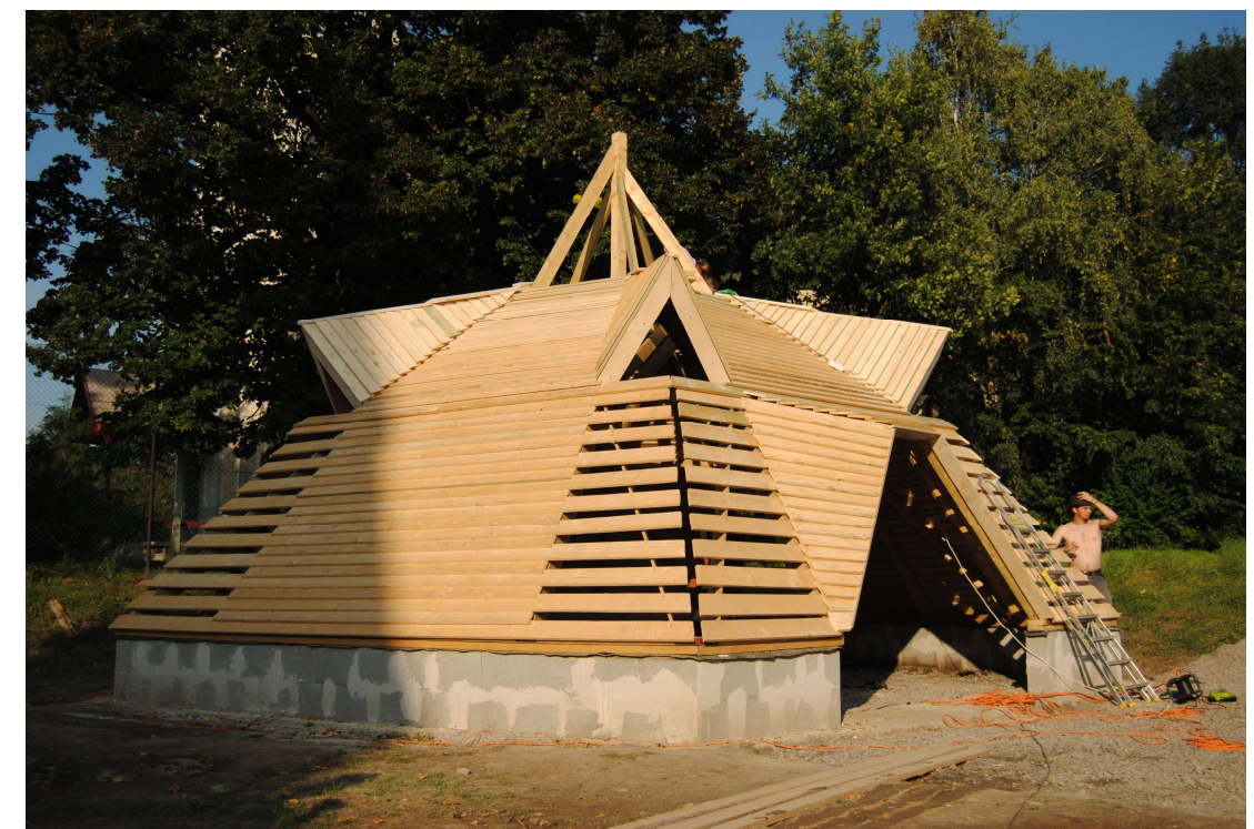
2. ábra Sárospatak, építőtábor, 2010. augusztus – a pavilon egy késői építési stádiumban
