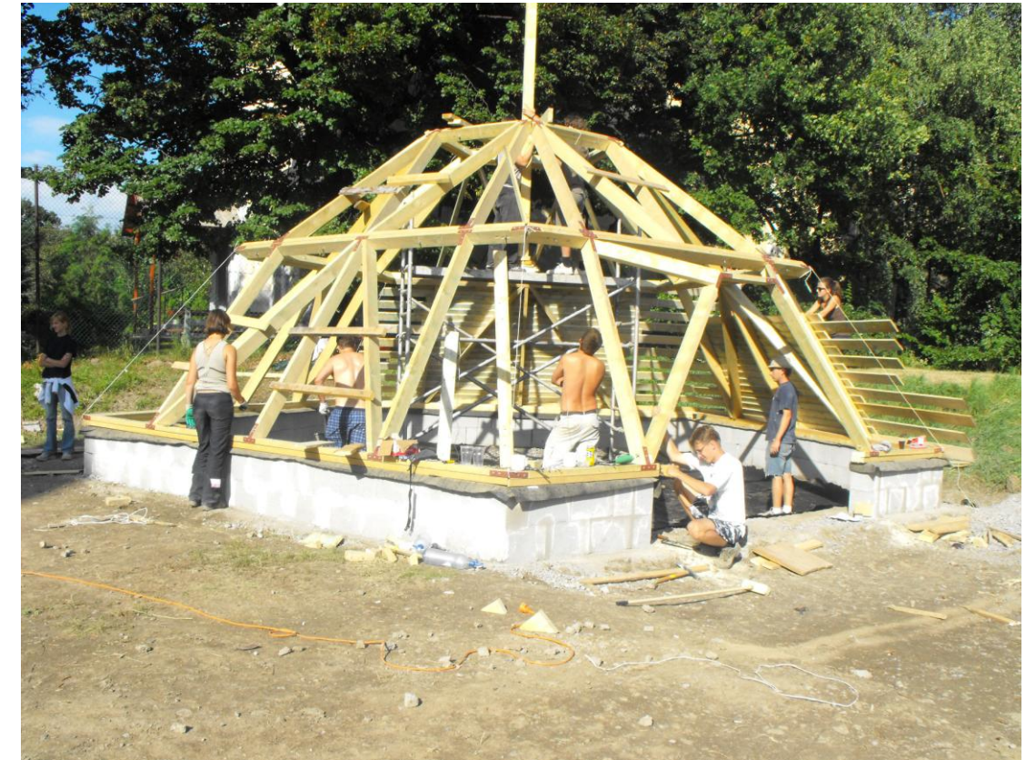
1. ábra Sárospatak, építőtábor, 2010. augusztus – a pavilon egy korai építési stádiumban
