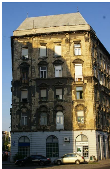
felújításra szoruló épület
