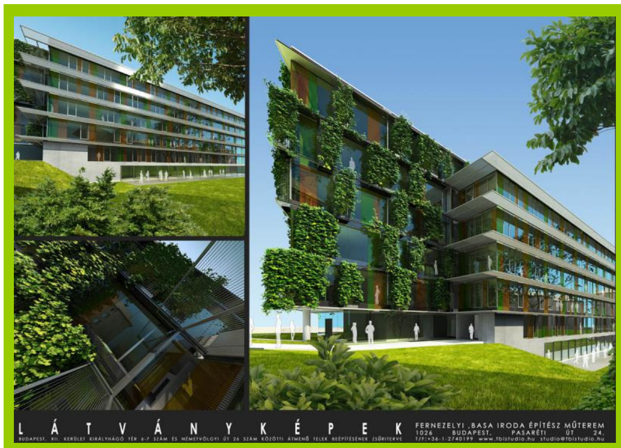
1.5.7. ábra: Zöldhomlokzat a Királyhágó téren [7] , FBI Építész Műterem
